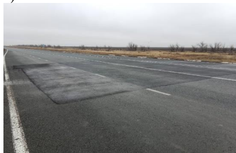
Рисунок 1 – Грунтовая дорога с использованием опоки (а), автомобильная дорога второй категории г. Уральск – р.п. Озинки (б), участок дороги над водопропускной трубой с основанием дороги с применением опоки (в), участок дороги с основанием из глины над водопропускной трубой после ремонта (г)
