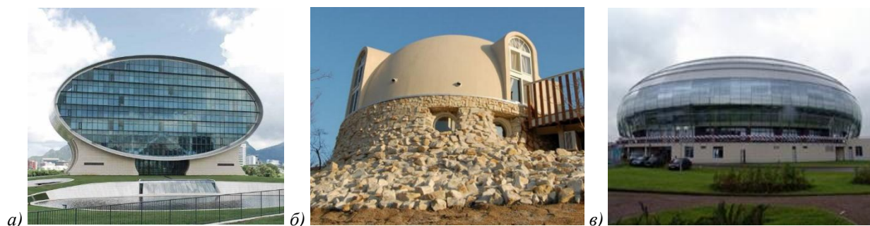
Рисунок 1 – Сооружения и здания криволинейных форм, построенные в начале XXI-го века а) Коммерческий банк Маврикия, 2010 г.; б) «Купольный дом XXI-го века из пенопласта объединения «BASKEY»; в) Спортивно – оздоровительный центр «Динамо», Москва, июль 2006 г.
