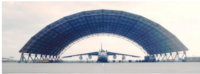
Рисунок 6 – Металлический уникальный большепролетный свод, ОАО «ГИПРОНИИАВИАПРОМ»
