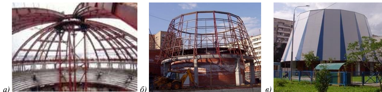
Рисунок 11 – Несущая ребристо-кольцевая стержневая структура (а) и трехслойная криволинейная структура с внутренним стержневым заполнением (б, в), Москва
