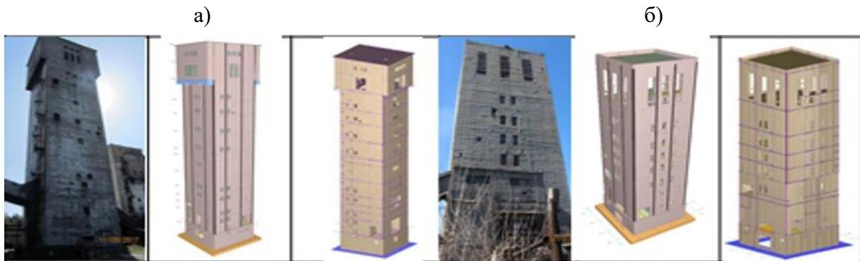
**Рисунок 5 - Примеры конструкций башенных копров, восстановленных по проекту ФГБОУ ВО «ДОННАСА»:**
