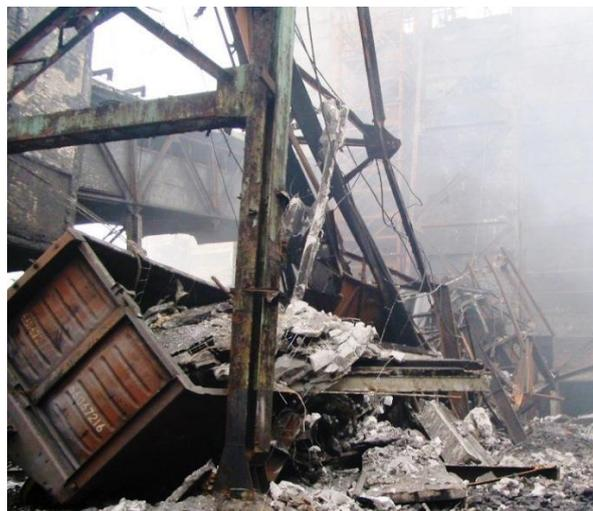
*Рисунок 1 – Последствия коррозионного разрушения конструкций и сооружений:
