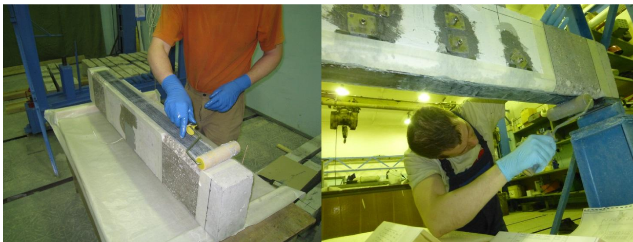
Фото 1 – Приклеивание углеродного холста на балку: а) для балок серии «б», б) для балок серии «в».
