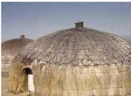
Рисунок 1 - Дом улья Зулу, построенный из канатной решетки, соломы и деревянных полос.
