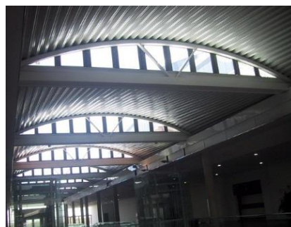
Рисунок 15 – Коноидальная крыша выставочного центра в Валенсии, Испания
