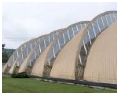
Рисунок 10 – Промышленное здание, Gossau, Швейцария
