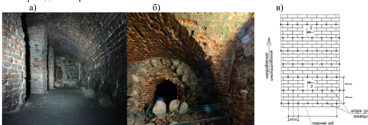
Рисунок 2 – Текущее состояние стен подвала замка Инстербург после укрепления кладки стен, и схема проведения укрепления кладки: а- текущее состояние подвала с видимыми следами проведенных инъекций (фото автора); б- фотография свода подвальной части (фото автора); в- схема проведения укрепления стен подвала
