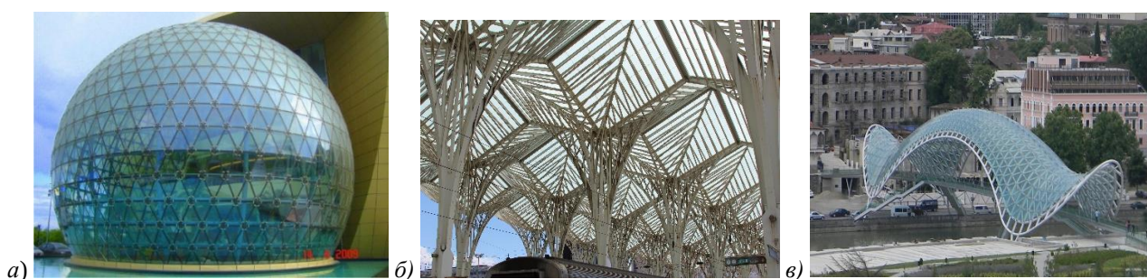
Рисунок 4 – Однослойные стержневые структуры а) «Балтийская жемчужина», http://www.cih.ru/j2/395.html ; б) вокзал в Лиссабоне, Португалия; в) мост через реку Куру, Тбилиси, Грузия.
