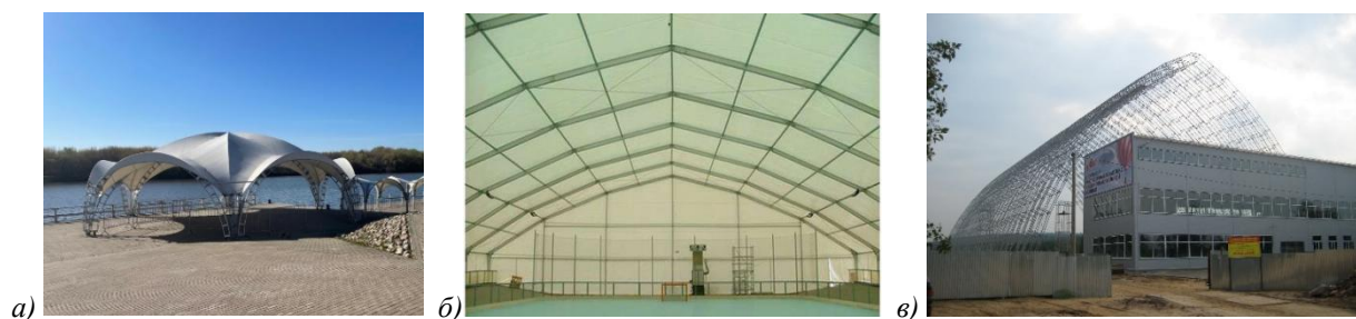
Рисунок 9 – Арочно-стержневые структуры из систем арок (а, в - Московская обл. и б – Азербайджан [vipsport.az])
