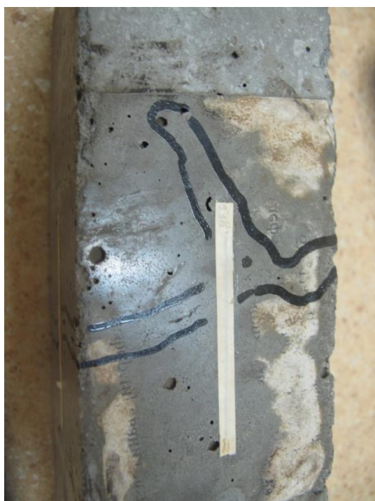
Рисунок 8 – Характер трещинообразования в бетоне контрольного образца арматурного проката А500С Ø16 мм, забетонированного в бетонной призме (В60), при многократно повторяющихся циклических нагрузках
