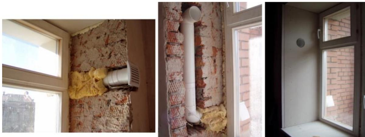
Рисунок 8 – Принципиальные решения воздухообменных клапанов для здания с кирпичными стенами
