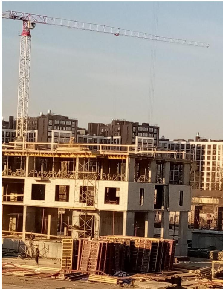
*Рисунок 2 – Возведение монолитного жилого здания в Санкт-Петербурге с использованием башенного крана с поворотной балочной стрелой и неповоротной башней на железобетонном фундаменте, вылет крюка крана изменяется при перемещении грузовой тележки (фотографии автора, 2023 г.):*
