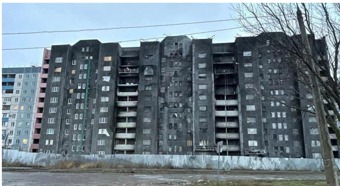
Рисунок 7 - Усиление несущей кладки стен, получившей повреждения в результате боевых действий, односторонними аппликациями из торкрет-бетона
