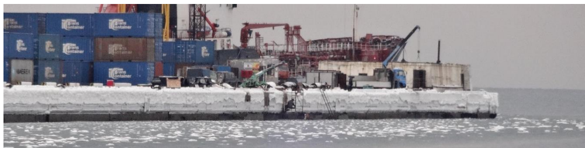
Фото 1 – Общий вид причального сооружения в зимний период (декабрь) в период отлива (фото автора)
