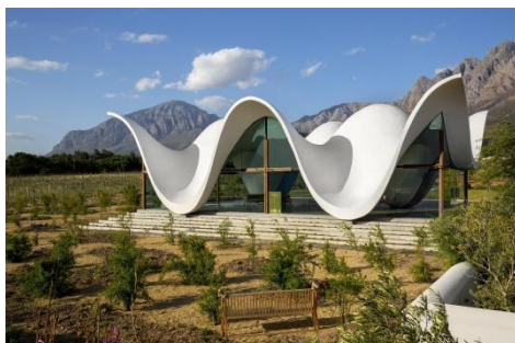
Рисунок 11 – Часовня Bosjes Capony, Western Cape, ЮАР, из литого бетона, 2016 г., (волнистая поверхность), арх. К. Стейн
