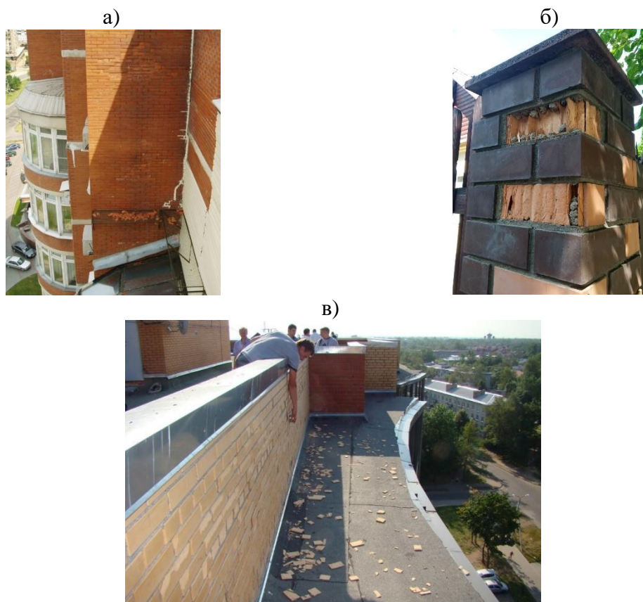
Рисунок 1 - Разрушение лицевого кирпича без воздействия внешних агрессивных химических сред или механических нагрузок: а) на фасаде, б) на столбе забора, в) на парапете
