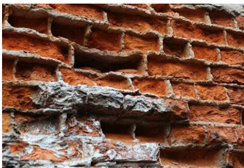
Рисунок 4 - Разрушение стеновой кладки из кирпича ручной формовки
