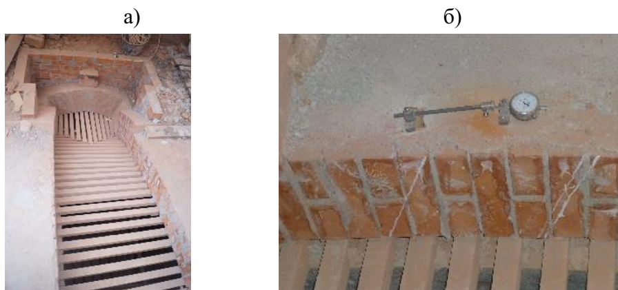
Рисунок 7 – Подпираание свода кружалами в местах устройства проема (а) с установкой измерительных приборов для отслеживания перемещений (деформаций) во времени (б)
