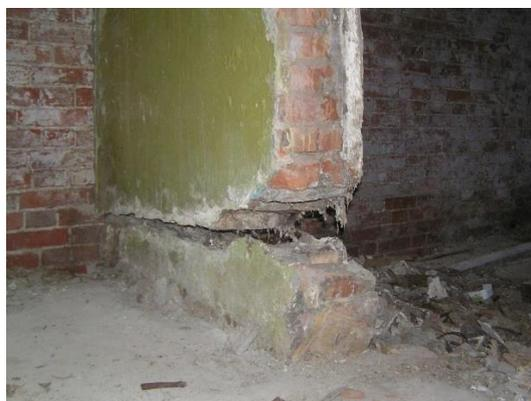
*Фото 1 - Деформации стен зданий, возведенных на деревянных сваях*
