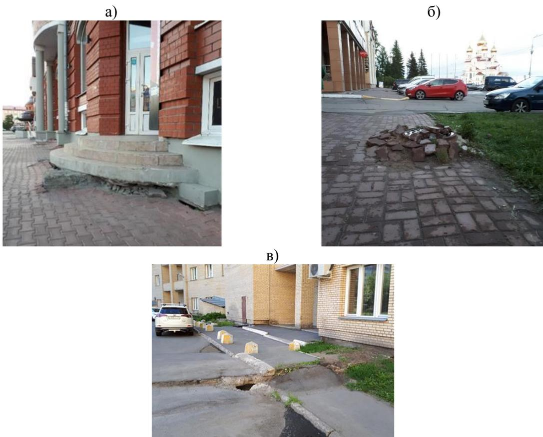
**Фото 2 - Деформации тротуаров, вызванные осадкой слоя торфа в основании:
