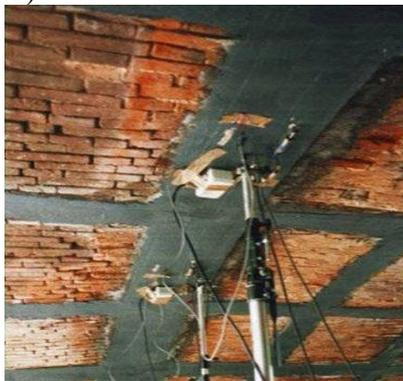
**Рисунок 2 - Армирование каменных сводов композитными материалами
