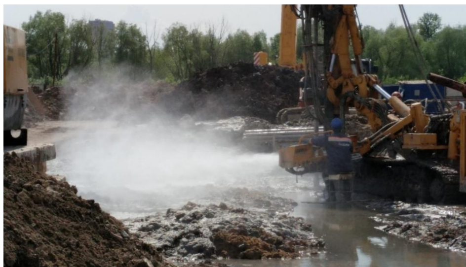
Рисунок 1 – Устройство jet-элементов
