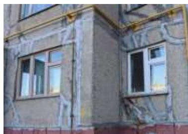
Рисунок 3 - Трещины в наружных стеновых панелях в следствие их перекоса
