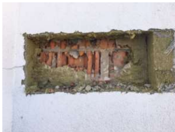
Рисунок 3 – Разрушение пустотелых керамических кирпичей
