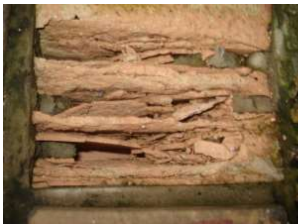
Рисунок 3 – Разрушение пустотелых керамических кирпичей
