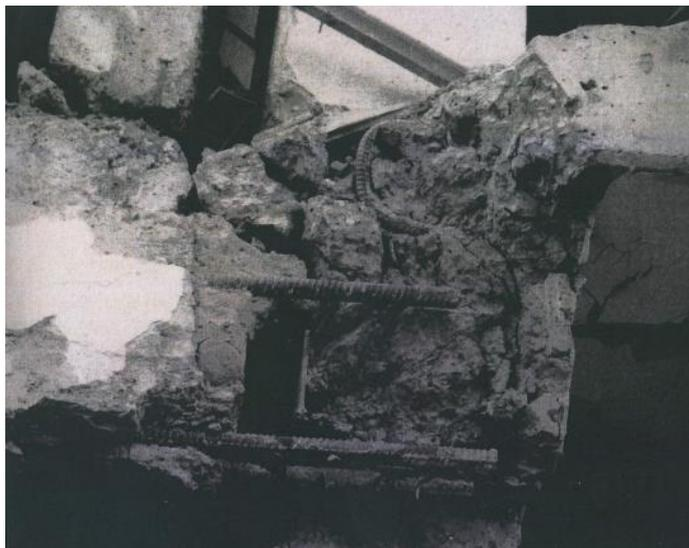
*Рисунок 3 – Разрушение узлов здания с железобетонным каркасом рамно-связевой конструктивной схемы. Непроектное выполнение узла (Спитакское землетрясение)*
