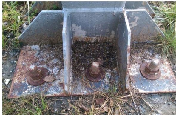
*Рисунок 8 - Коррозионное повреждение стальных элементов базы опорной стойки*
