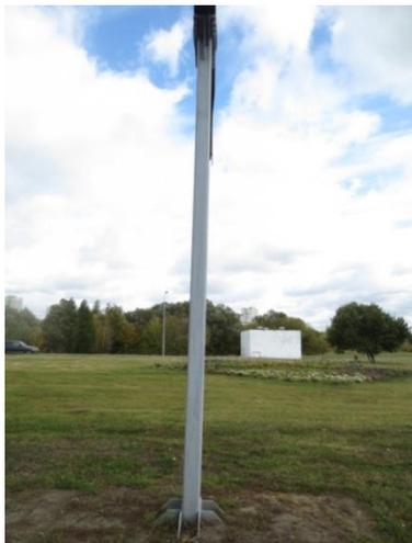
*Рисунок 5 - Отклонение конструкции рекламного щита от проектного положения*
