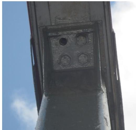
*Рисунок 6 - Отсутствие крепежных элементов верхнего узла крепления опорной стойки*
