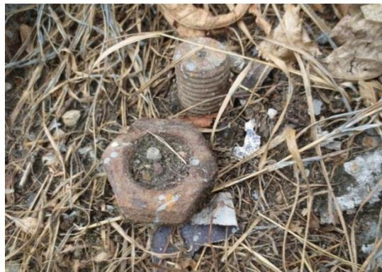
*Рисунок 7 - Ослабление затяжки нижнего узла крепления опорной стойки*
