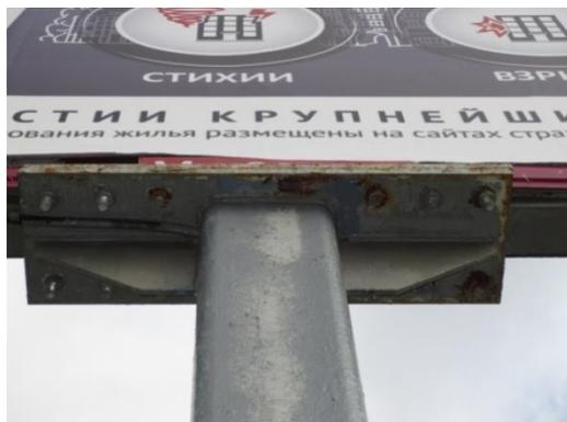
*Рисунок 9 - Коррозионное повреждение стальных элементов верхнего узла крепления опорной стойки*
