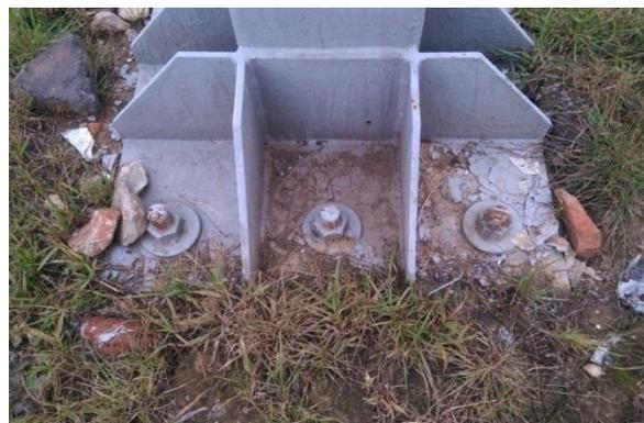
*Рисунок 10 - Разрушение защитного антикоррозионного покрытия по поверхности стальных элементов*
