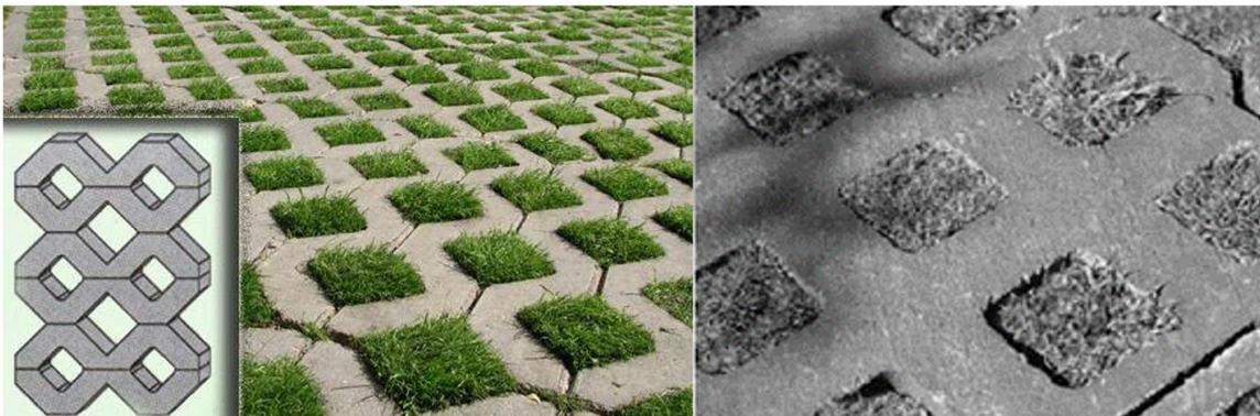
Рисунок 5 – Перфорированная тротуарная плитка «Газонная решетка» с включенным в отверстия высокопроницаемым бетоном [19]
