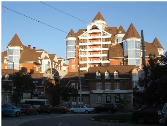
Рисунок 2 - Восьмиугольные призмы с вертикальными осями и с восьмиугольными пирамидальными крышами, г. Краснодар
