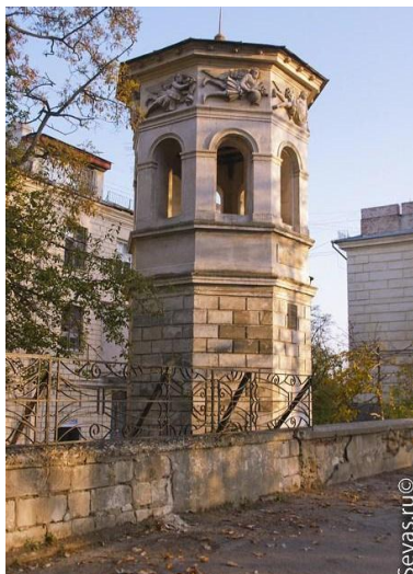
Рисунок 1 - Башня ветров, г. Севастополь
