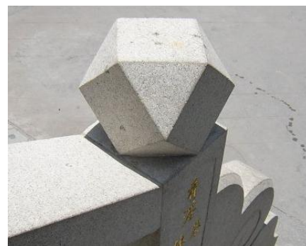
Рисунок 30 - Фрагмент ограждения лестницы
