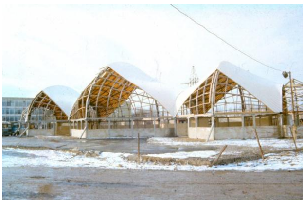
Рисунок 3 - Рынок в г. Махачкале в процессе строительства
