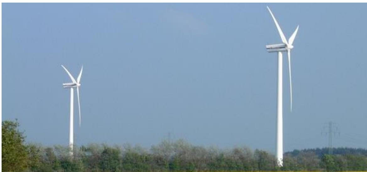
**Фото 1 – Ветроэлектрическая установка Acciona AW-82-1500 класса IEC IIIВ**
