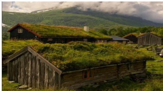
Рисунок 1 - Применение дерновой крыши в конструкции дома, Норвегия (Источник: http://masterok.livejournal.com/1021339.html )
